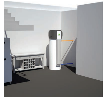
Ohne Kanalanschluss: erforderliches Raumvolumen: min. 30m 3
